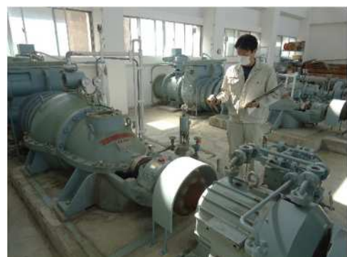
機械設備点検の様子
